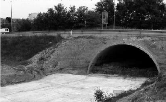
6 Suposada barrera "natural" de la subestació elèctrica
